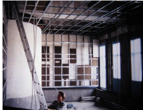
Abb. 2 HF Studio, Montage der flachen Schallabsorber an Wänden und an der Decke
